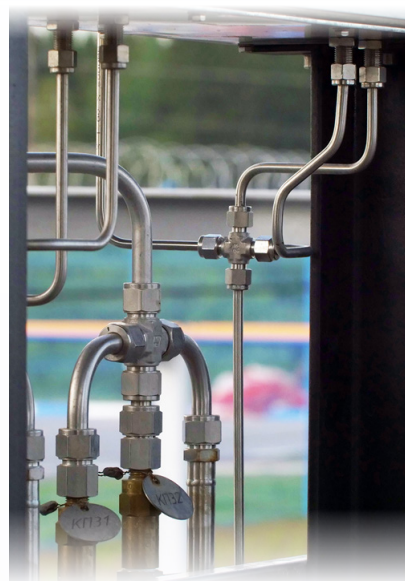
Рис. 3. Пример использования фитингов на АГНКС
